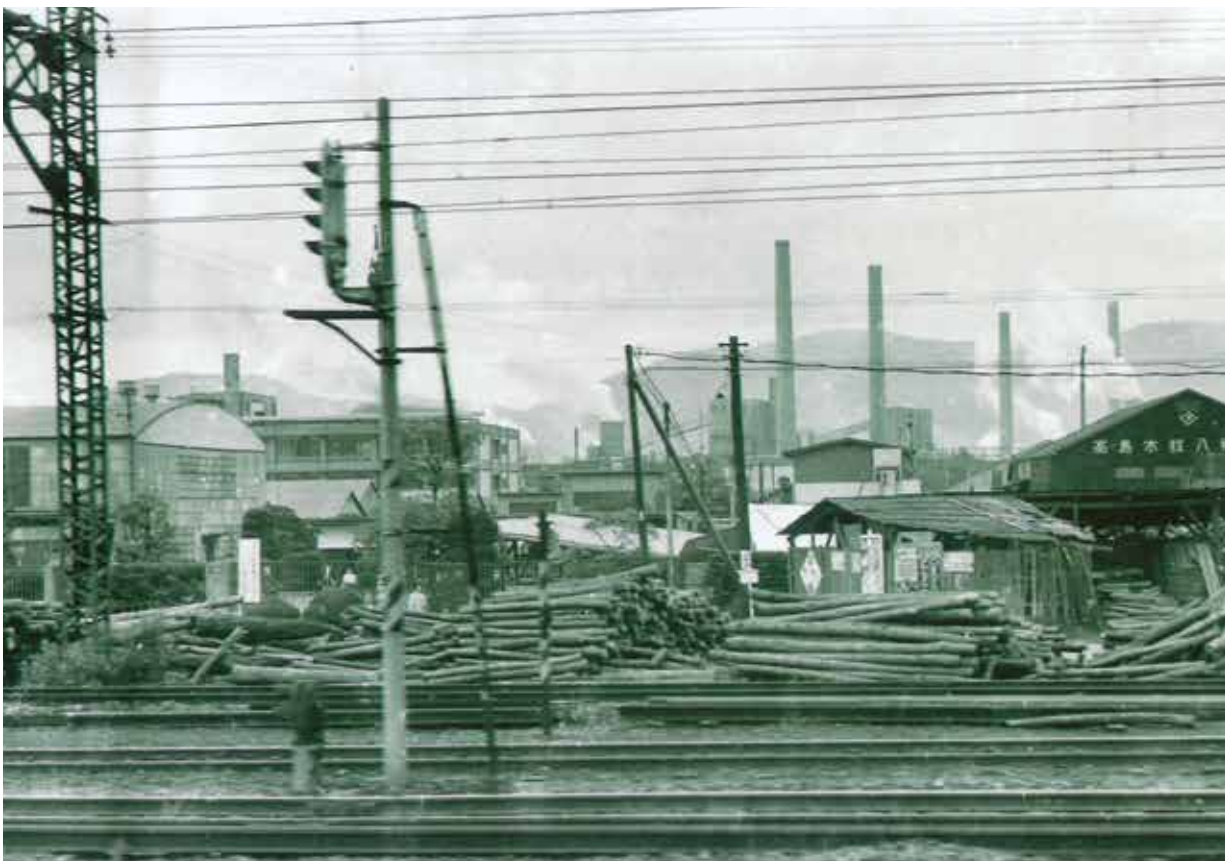
高島木材八幡工場
